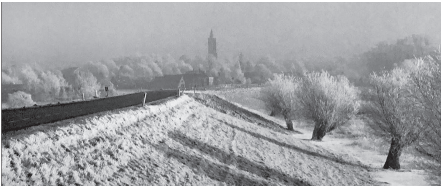
▲ De Lekdijk bij Amerongen (achtergrond). De knotwilgen aan de voet van de dijk staan in de zogenaamde 'zoodslag', in de loop van de tijd verbasterd tot 'doodslag'. (Uit: A.A.B. van Bommel, "De Lekdijk van Amerongen naar Vreeswijk", Uitgeverij Verloren te Hilversom, 2009).
