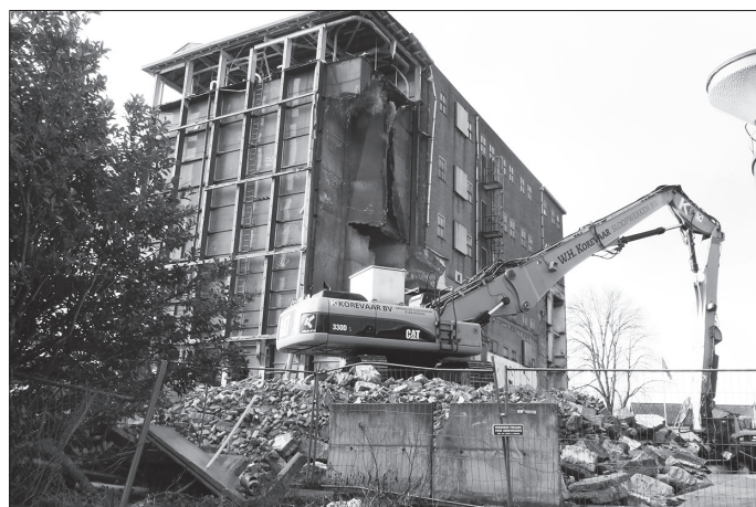
▲ Begin 2021 is de meelfabriek volledig gesloopt en wordt een groot deel van het terrein gereed gemaakt voor de bouw van nieuwe woningen (foto Cees van der Grijn).
