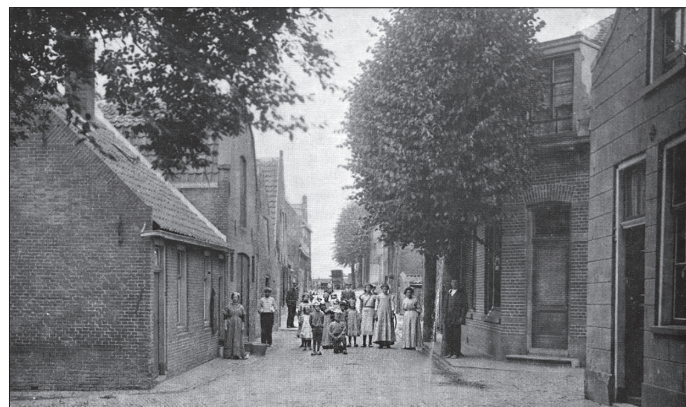
▲ Benedendamschestraat Ameide ca. 1920? Uiterst rechts de woning van het gezin Oosterom (no. 38). Links daarnaast de kruidenierswinkel van Kruijt op no. 36. Later wordt dit pand het kantoor van de meelfabriek (foto website HVAT).
