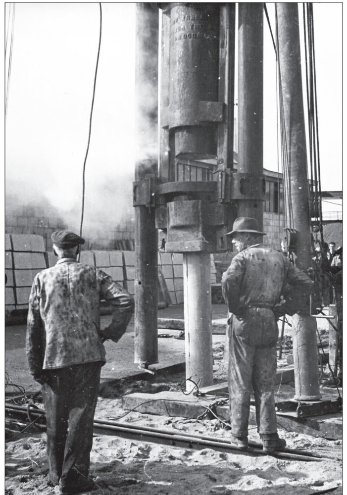
▲ In 1951 werd de eerste paal geslagen voor de nieuwe bouwen buizenfabriek.
