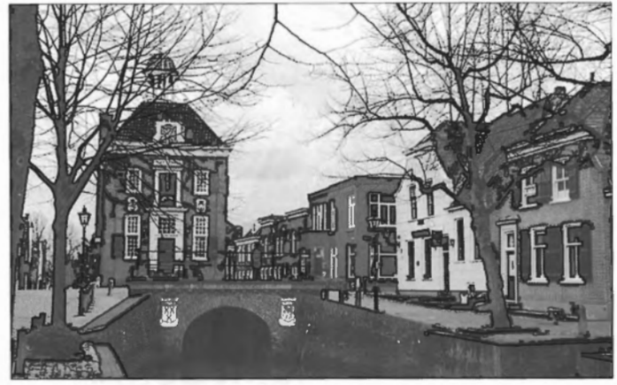
Stadhuis van Nieuwpoort in 1697 gebouwd over de inundatiesluis (foto Wikimedia).
