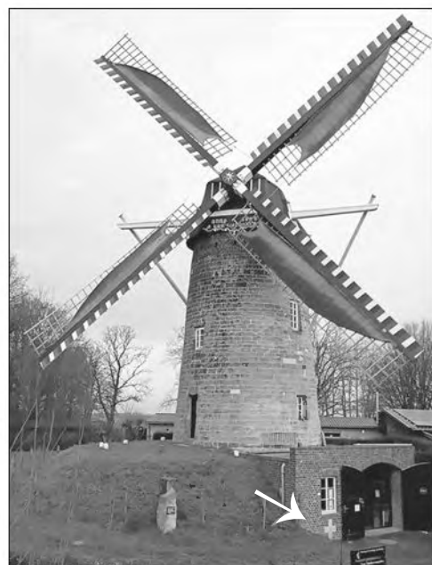
▲ De volledig gerestaureerde en weer maalvaardige Van Tienhovenmolen, Wolfshuis (Bemelen). (Naast de opengeklapte deur is onder het raam het zgn. moordkruis ingemetseld) (Foto Koen van der Maat 4 , molenaar, 23-12-2021).
