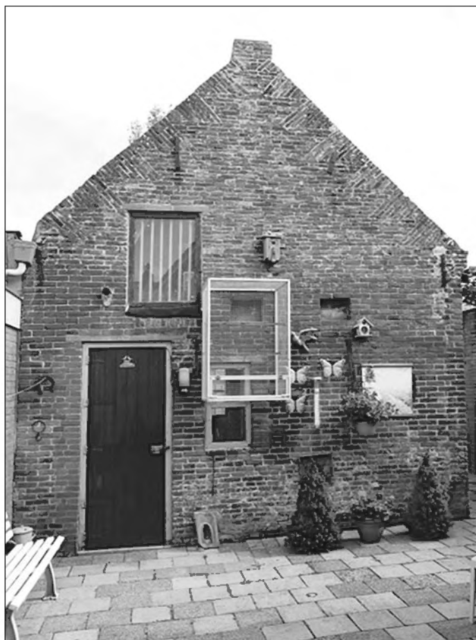
▲ Voorgevel van de schuur.
