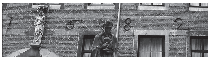
▲ Jaartal 1682 in de muurankers van de voormalige proosdij. (Foto: Kleon3, 2016, detail. Wikimedia).
