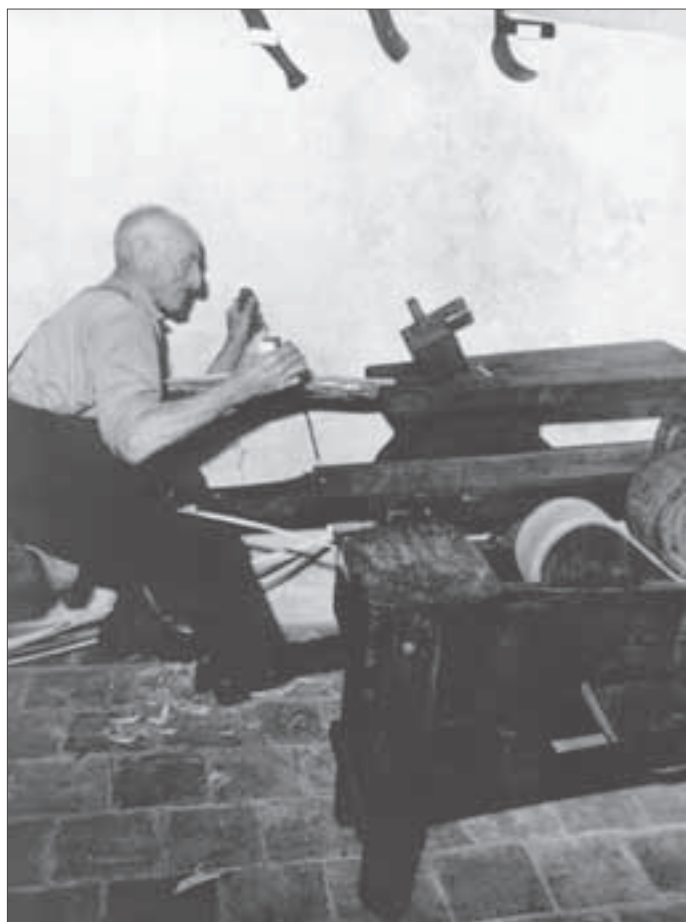
Op de snijbank wordt de vlakke kant van de gesplitste tak egaal gemaakt.
