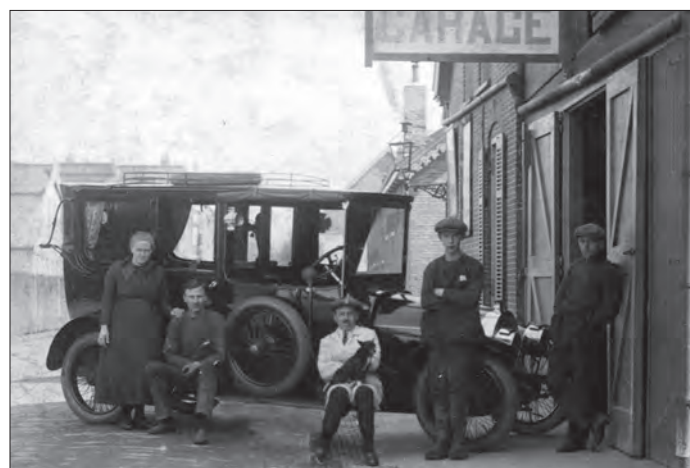
▲ Naast de winkel had Hamoen een garagebedrijf met een benzinepomp. Later is dit bedrijf overgenomen door Theo Rozendaal. Er zijn plannen om op deze plaats appartementen te bouwen.
