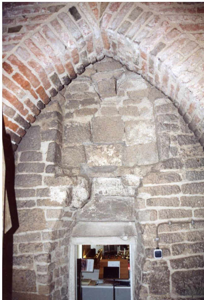
Afbeelding 8. Oorspronkelijke toegangspoort in westgevel. (foto: André Tukker)
