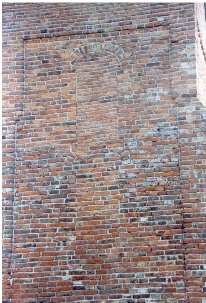
Afbeelding 10. Boogaanzetten van de dichtgemetselde galmgaten. (foto André Tukker)
