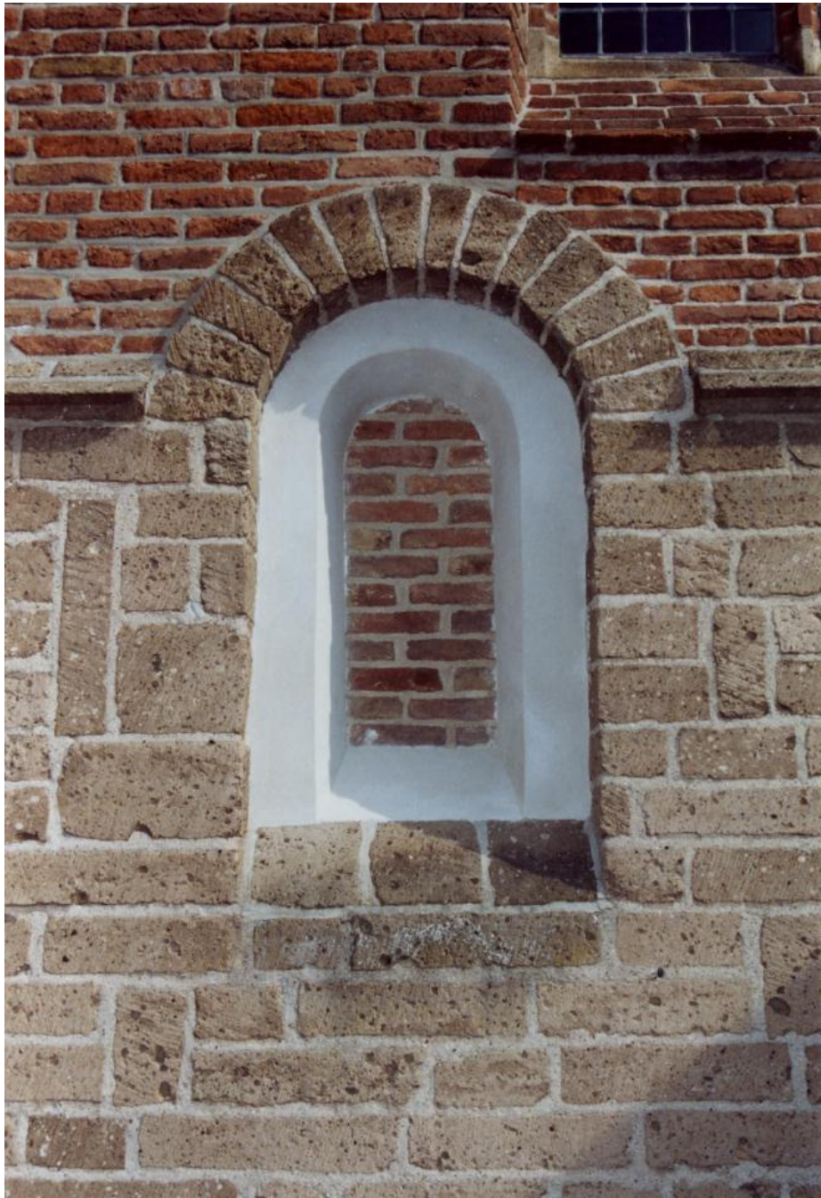
Afbeelding 2. Gerestaureerd dichtgezet raam in de zuidmuur van de kerk. (foto André Tukker)
