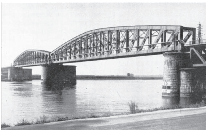
Brug Baanhoek (de brug over de Merwede).
