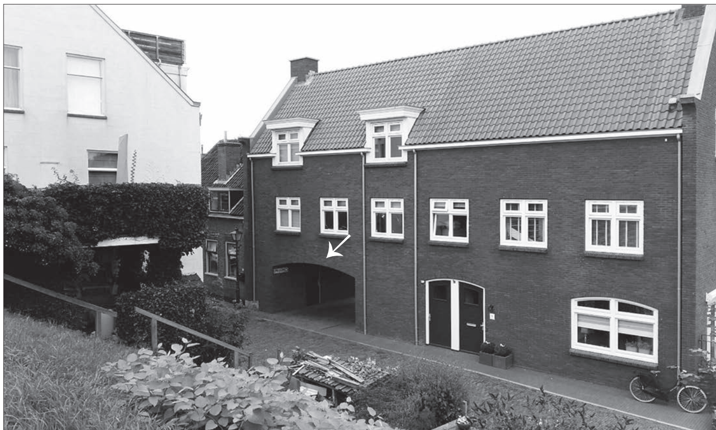
▲ De nieuw gebouwde entree (zie pijl) van de Gerrit Roodhorsthof aan de Peperstraat.
